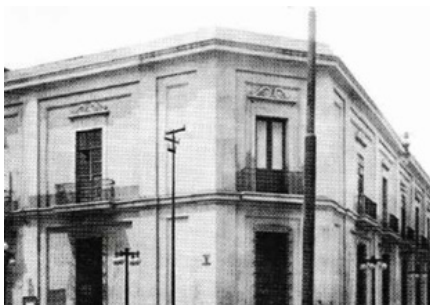
Figura 3. Palacio episcopal de Guadalajara (arriba). Demolición (abajo).
