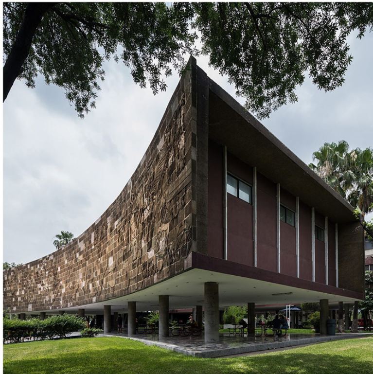
Figura 12. Facultad de Ingeniería Civil, Ciudad Universitaria de Nuevo León, 2019. Fuente: The Raws (2019).
