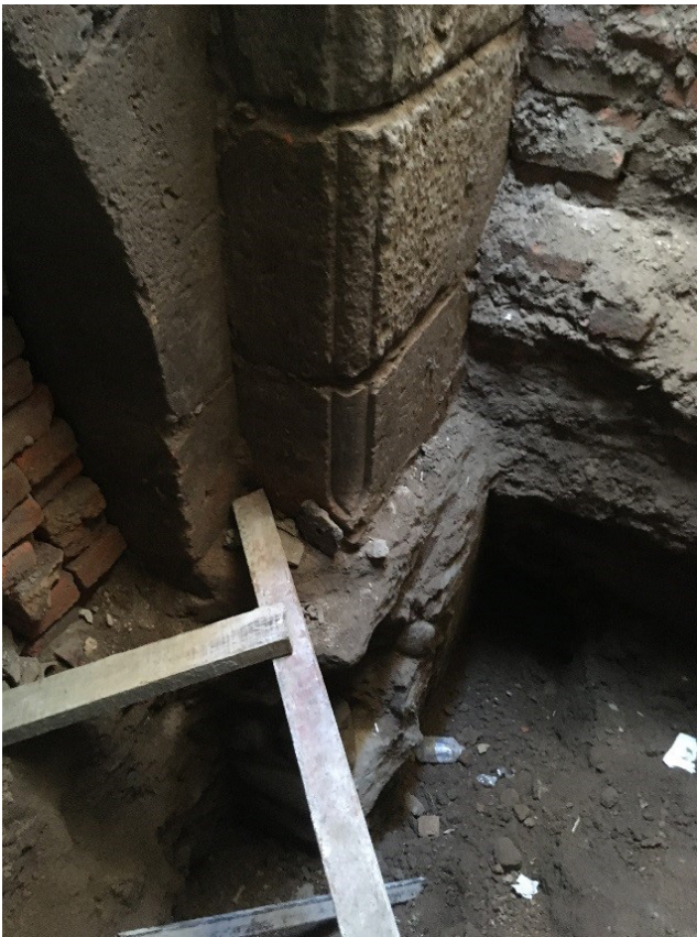
Figura 9. La documentación arquitectónica sobre el puente se complementó con los hallazgos de la segunda etapa como las pilastras de la parte oriente. Fotografía: Ignacio Gómez Arriola, 2017.
