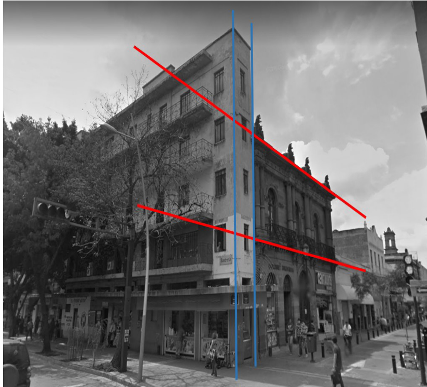
Figura 3: Avenida Juárez 470. Se puede observar el ancho de apenas dos metros del terreno (líneas azules) y la falta de relación con el edificio patrimonial. Fuente: Rosa M. Sánchez Sosa y Carlos A. Bravo Wagner.
