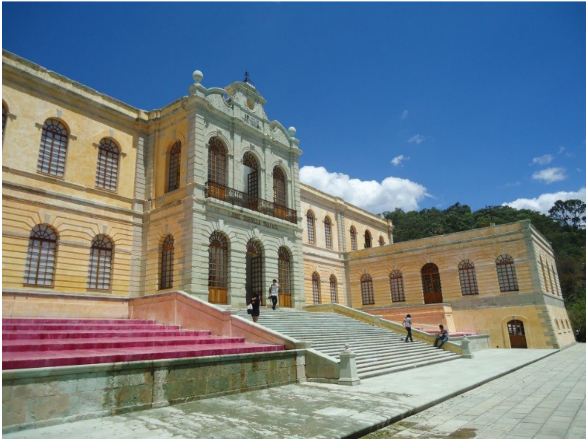
Imagen 8. Acceso sur del edificio fabril. Fuente: Archivo CAPUAO.
