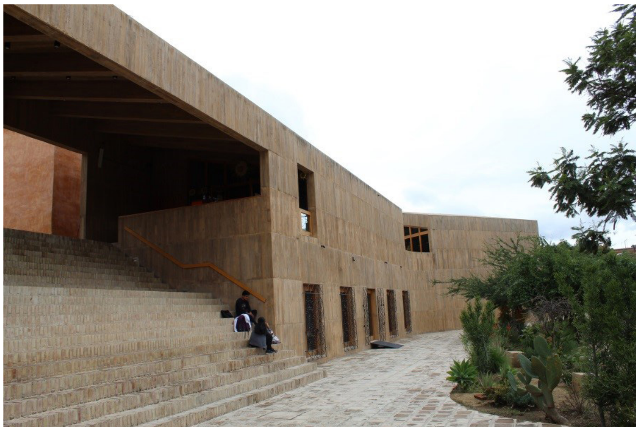
Imagen 14. Escalera articuladora de niveles en el Centro Cultural Comunitario. Autor: Fabricio Lázaro. Archivo: CAPUAO.
