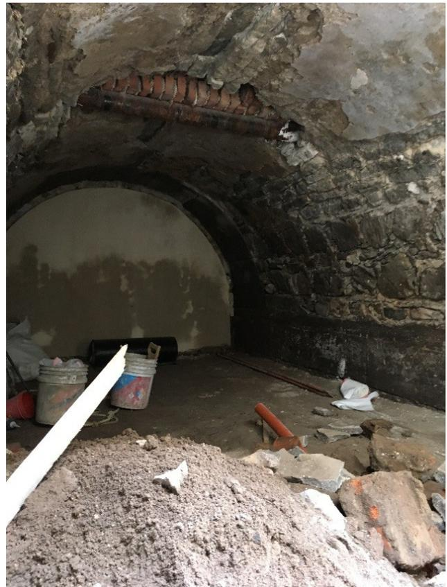
Figura 10. Como parte de los trabajos de documentación se pudieron identificar tres líneas de infraestructura que afectaron al puente, una de drenaje inferior, otra de conducción de agua y la tercera, para distribución de agua local. Fotografía: Ignacio Gómez Arriola, 2017.
