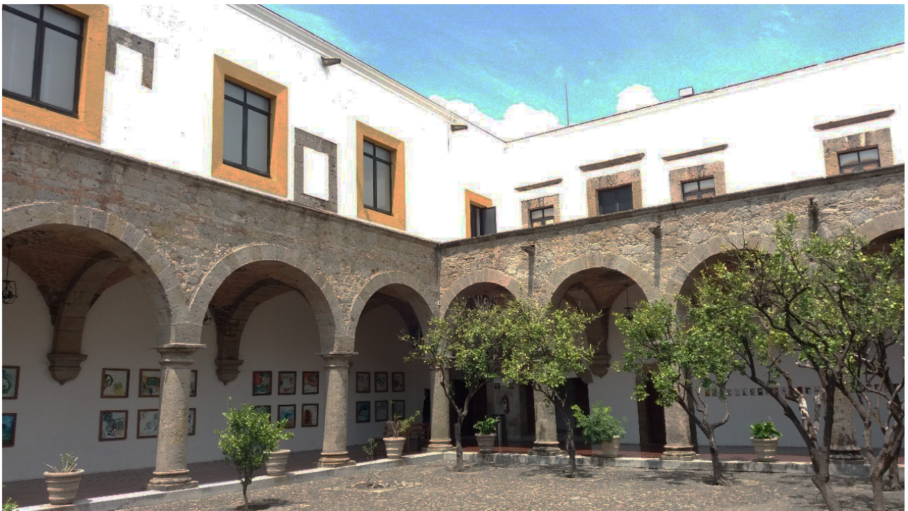
Figura 13. Situación actual del claustro de servicios o menor. Fuente: Archivo propio, 2020.
