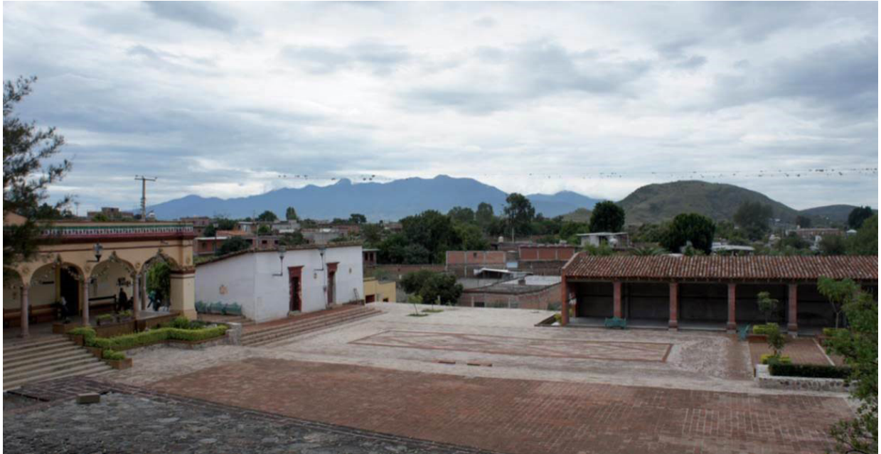
Imagen 9. Liberación de acceso al terreno para el Centro Cultural Comunitario. Autor: Taller Productora.
